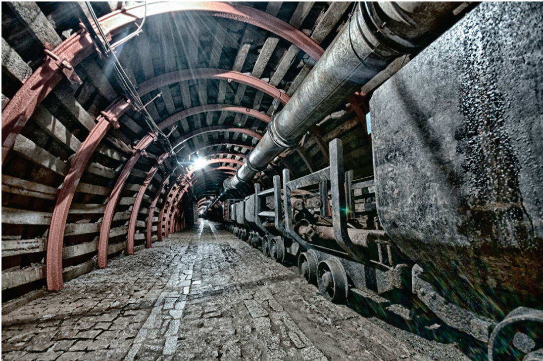
Abbildung 3: Mit 3,5 Mio. t CO 2eq entstammen dem Sektor 1B Flüchtige Emissionen aus Brennstoffen im Jahr 2019 1,5 % der Gesamtemissionen Nordrhein-Westfalens. Etwas mehr als Hälfte der Emissionen entsteht im Bereich der festen Brennstoffe, z. B. aus stillgelegten Steinkohlezechen (Quelle: Panthermedia/trybex).
