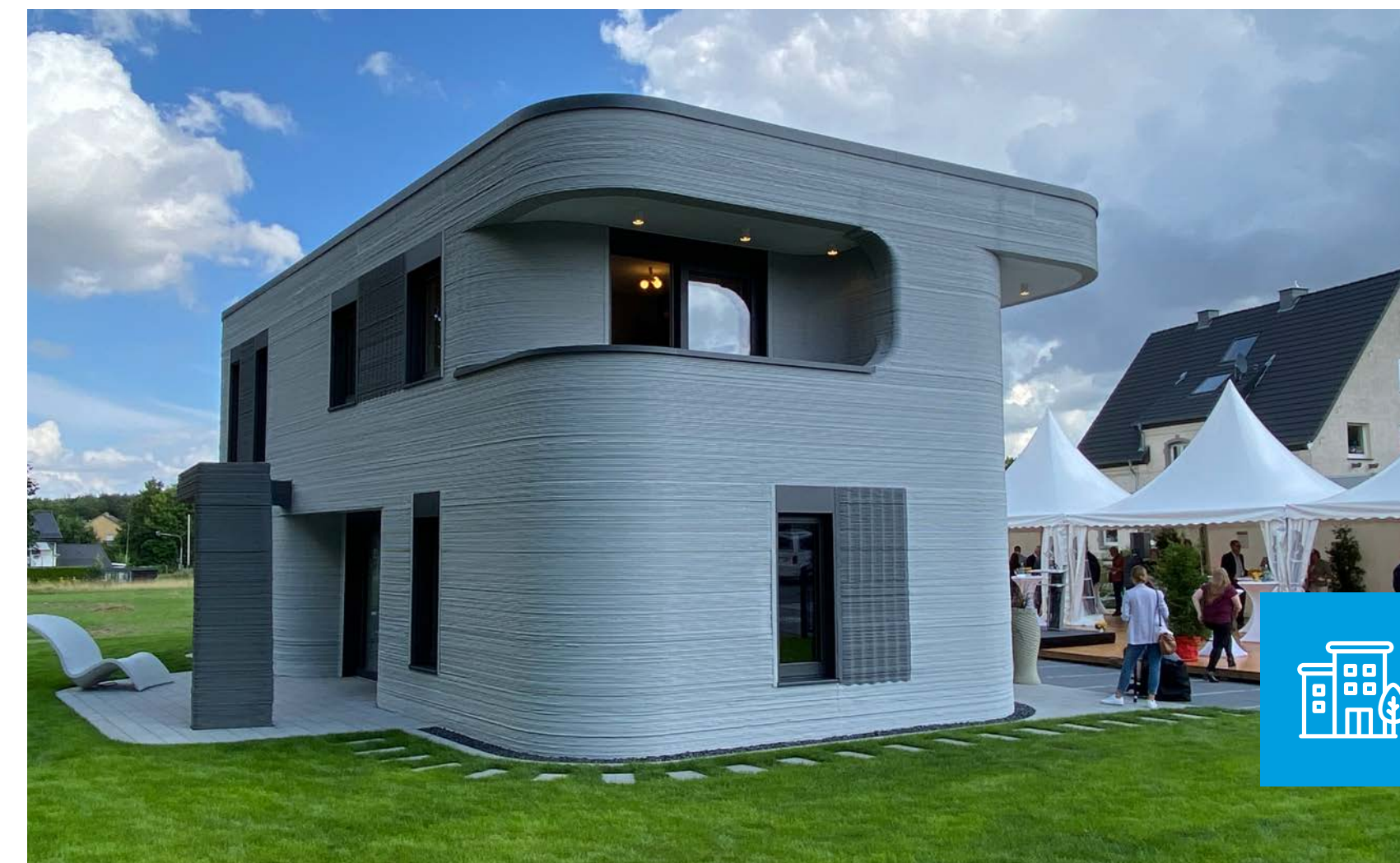
Das erste zweigeschossige Wohnhaus aus 3D-Betondruck steht in Beckum. Das Bauverfahren wurde 2021 mit dem „German Innovation Award“ ausgezeichnet.
