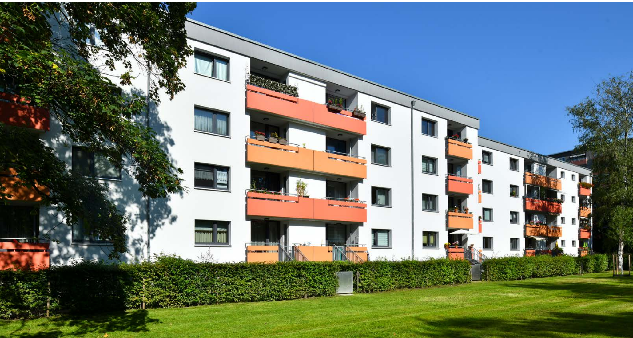
Best-Practice- Modernisierung in der Kannebäcker- siedlung Köln
